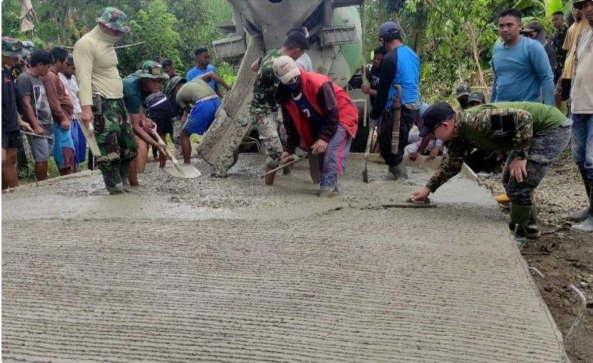
Satgas Tentara Manunggal Membangun Desa(TMMD) yang dibantu masyarakat setempat mengerjakan pekerjaan pengecoran plat Dekker dan pengecoran rabat beton dengan target seluruh sasaran fisik selesai sesuai waktu yang telah ditentukan.
